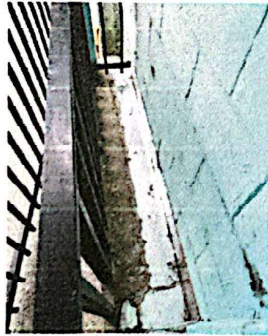
Foto 9: Colocación de Flashing para generar el sello en la junta de dilatación del módulo de gradas y el módulo de aulas, para evitar problemas de humedad.
