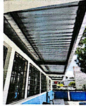
Foto 8: Instalación de láminas troqueladas nuevas.
