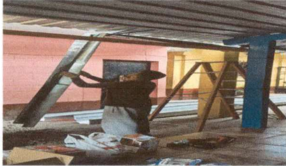
COLOCACION DE CANALES
