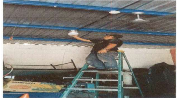
COLOCACION DE FLAPONERAS Y BOMBILLAS
