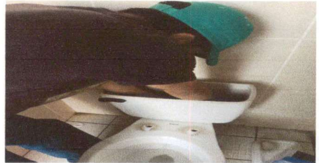
REPARACION DE SANITARIOS
