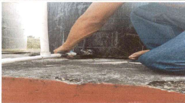
REPARACION DE TINACO
