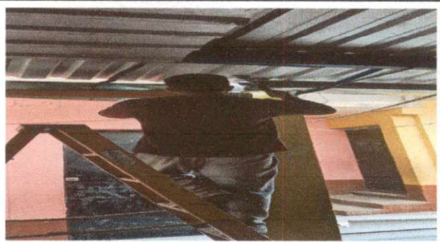
COLOCACION DE CANALES
