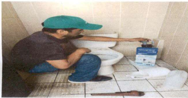
CAMBIO DE ACCESORIOS DE SANITARIOS
