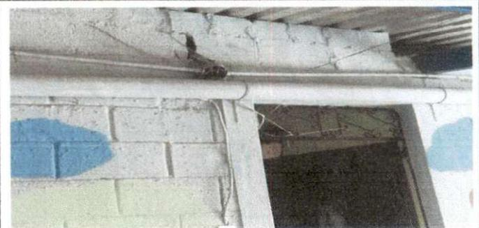
cables electricos expuestos y en mal estado
