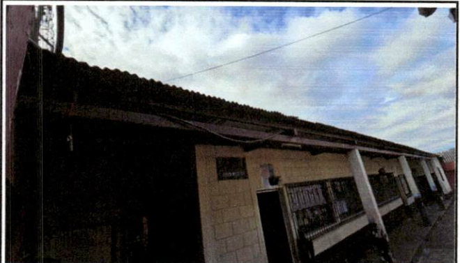
Foto 10: SUMINISTRO E INSTALACION DE CANAL TROQUELADO
