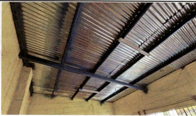
Foto 9: COLOCACION DE CIELO FALSO EN AULA
