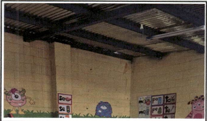
Foto 8: SUMINISTRO DE CIELO FALSO EN AULA DE CENTRO EDUCATIVO
