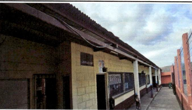
Foto 11: MEJORAMIENTO DE TECHO EN AREA RECREATIVA.
