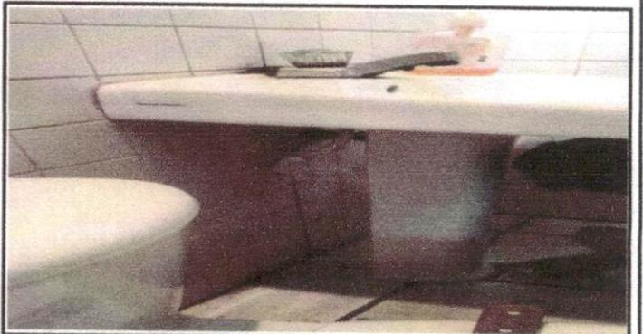
Foto 6: Imagen que muestra la reparación de la fuga de agua en lavamanos en sanitario de maestras.
