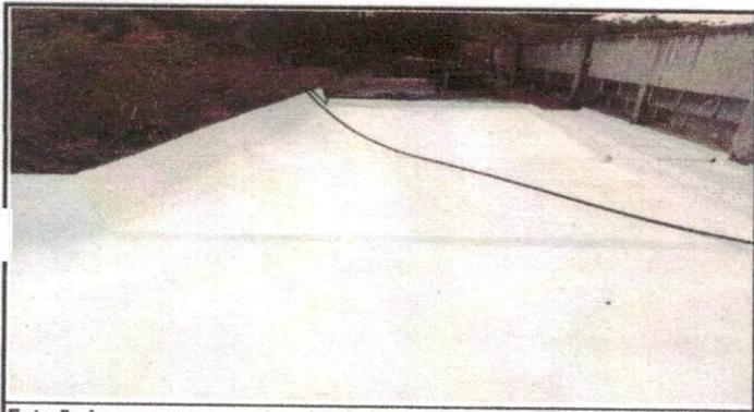
Foto 5: Imagen que muestra el trabajo terminado del mantenimiento, limpieza y colocación del impermeabilizante.
