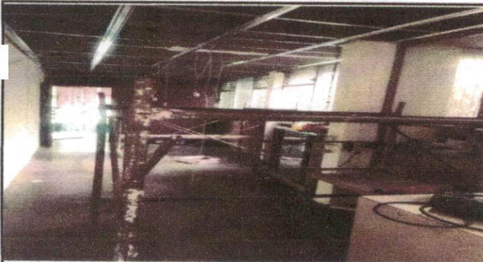
Foto 3: Imagen que muestra el estado de desmontaje de cielo falso área administrativo: Secretaria, contabilidad, dirección, subdirección y dos bodegas.
