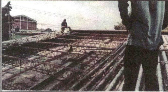
Foto1: Imagen que muestra el desmontaje de Lamina (duralita) Área Administrativa: Secretaria, contabilidad, dirección, subdirección y dos bodegas.
