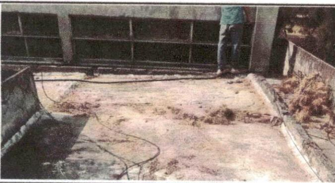
Foto 5: Imagen que muestra el estado de la terraza para realizar el mantenimiento y la limpieza para colocar el impermeabilizante.
