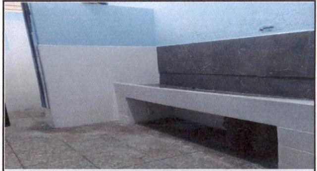
Foto 4: Reparación de mingitorio, tubería de agua potable, azulejo, puertas, cambio de lavamanos y pintura en servicio sanitario de alumnos.
