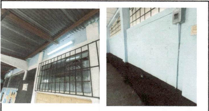
foto 4: Pintura y reparación eléctrica de salones del 2do. Nivel
