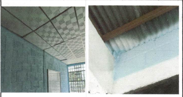
Foto 2 Reparación de techo y ventanas de salones del 2do. Nivel.
