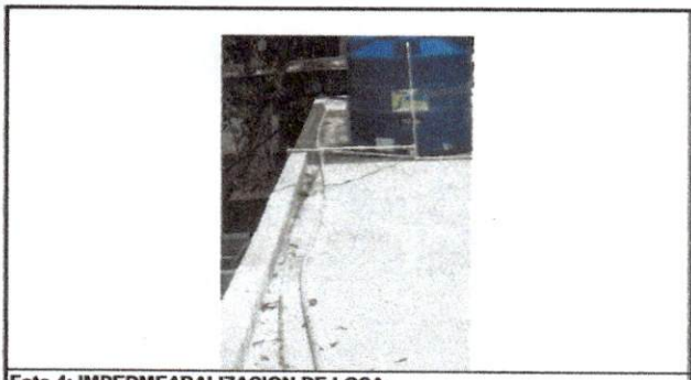
Foto 4: IMPERMEABILIZACION DE LOSA
