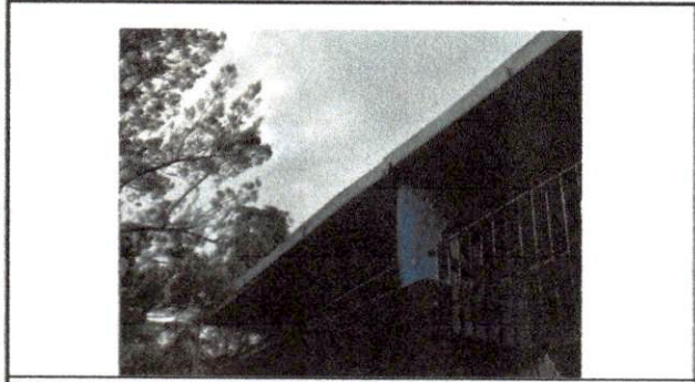
Foto 3: REPARACION DE CANALES Y BAJADA DE AGUA
