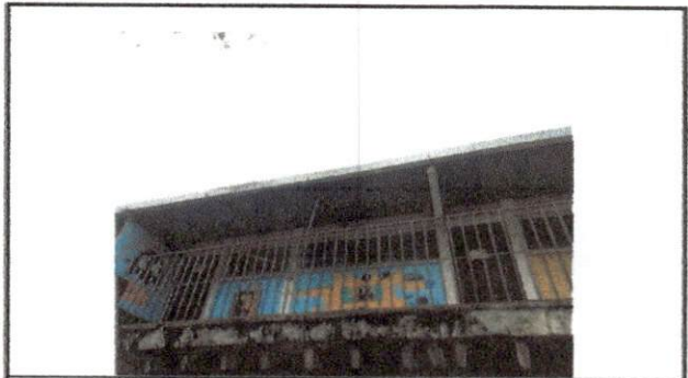
Foto 4: REPARACION CUBIERTA DE LAMINA
