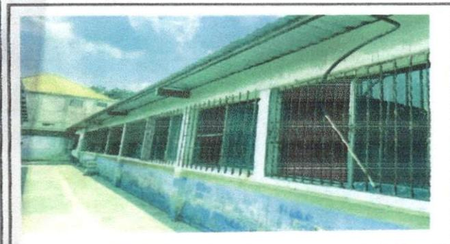
Foto 3: IMAGEN QUE MUESTRA LA PARTE LATERAL ZQUIERDO DEL MÓDULO YA CON LAS ESTRCUTURAS METÁLICAS Y LAMINA TROQUELADA.
