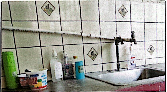
Foto 6: Acometidas de agua potable sobrepuestas, mal instaladas.
