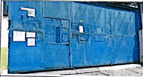
Foto 3: NECESITA UNA GUÍA ABAJO PARA QUE CORRA LIBREMENTE
