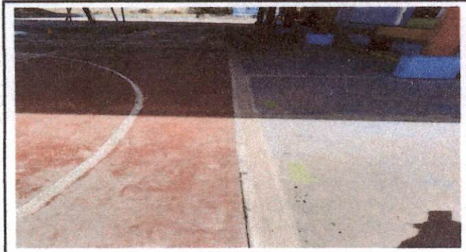
Foto 1: Reparación de piso curcha techada
