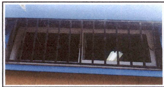
Foto 6: Sustitución de vidrios enterrameña
