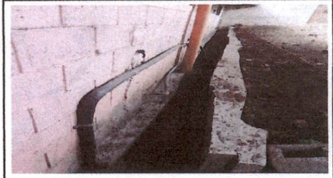
Foto 2: Reparación Cunetas area salón de manualidades
