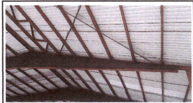
Foto 4: Sustitución lámina de curcha techada
