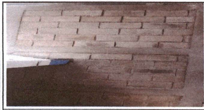
Foto 5: Sustitución de muros de lámina por muros de block
