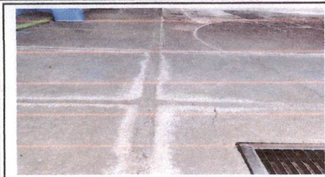
Foto 1: Reparación de piso cancha techada
