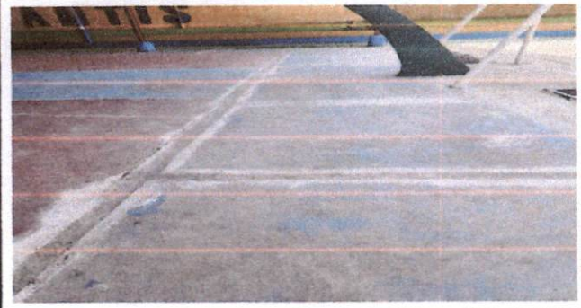
Foto 2: Reparación de piso cancha techada
