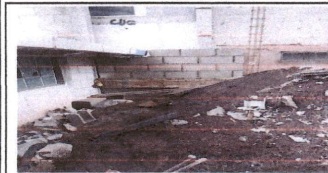
Foto 5: Reparación de Cuneta de Salón manualidades
