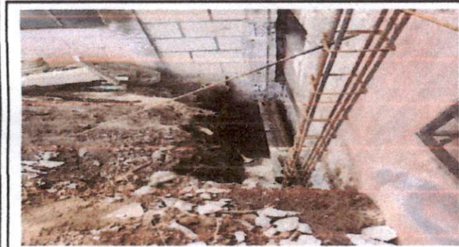
Foto 3: Reparación muro Perimetral
