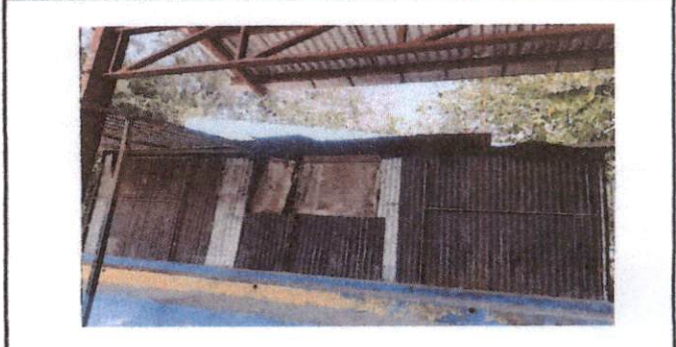
Foto 2: Sustitución de lamina en bodega por filtraciones.
