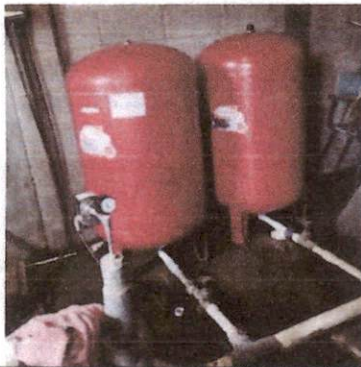
Foto 3: INSTALACION DE TANQUE HIDRONEUMATICO
