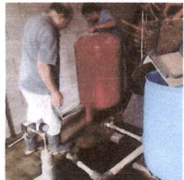
Foto 5: INSTALACION DE TANQUE HIDRONEUMATICO
