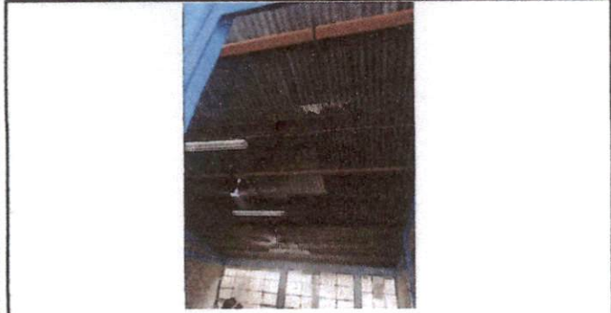
Foto 1: Sustitución de Lamina en aula Daniel Hernandez por filtraciones y aumento de calor
