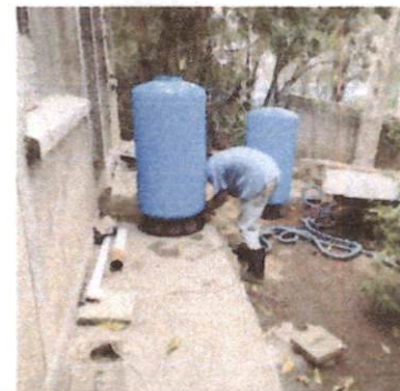
Foto 6: INSTALACION DE TANQUE HIDRONEUMATICO
