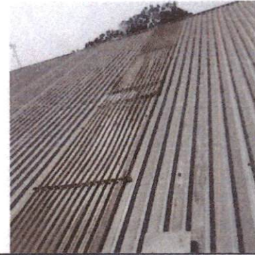
Foto 2: SUSTITUCION DE LAMINA
