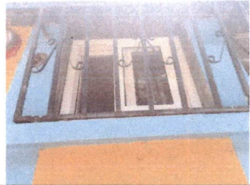
Foto 4: REPARACION DE VENTANAS ROTAS
