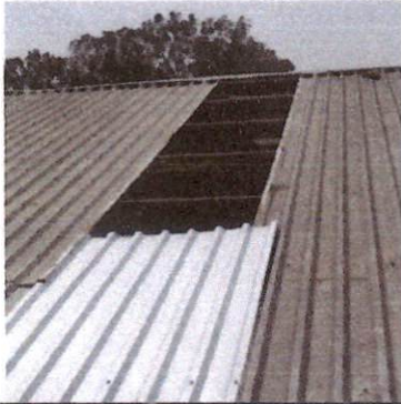
Foto1: SUSTITUCION DE LAMINA
