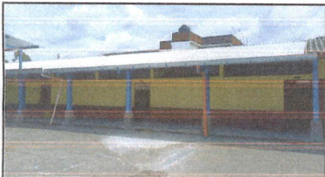
Techo, canal, reforzamiento de columnas, pintura terminados en las clases de segundo B y primero C.
