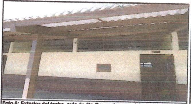
Foto 6: Exterior del techo, aula de 5to B y costaneras del corredor.
