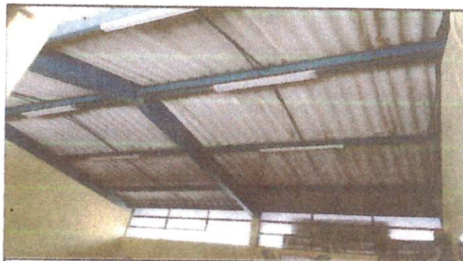
Foto 4: Interior del techo, aula de 1ro C
