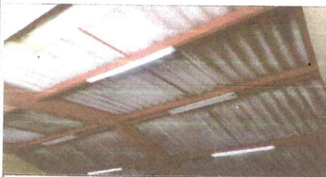
Foto 5: Interior del techo, aula de 5to B
