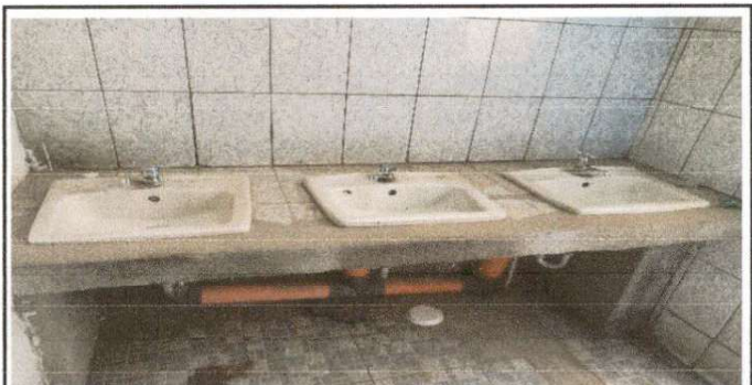
Foto 6: AREA DE LAVAMANOS
