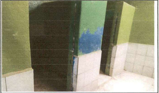
Foto 10: COLOCACION DE PUERTAS
