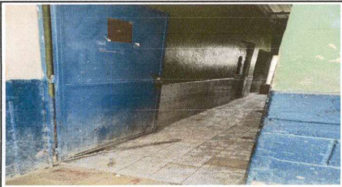
Foto 3: ACCESO DE SERVICIO SANITARIO PARA NIÑAS
