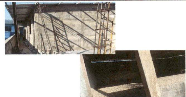
Foto 6: reparación de repello y cernido en paredes y puertas y ventanas
