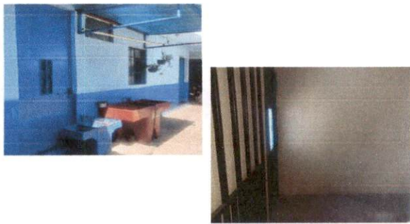
Foto 3: Reparación o sustitución de área de cocina (estufas rurales, pilas, ventanas, puertas, chimeneas, etc).
