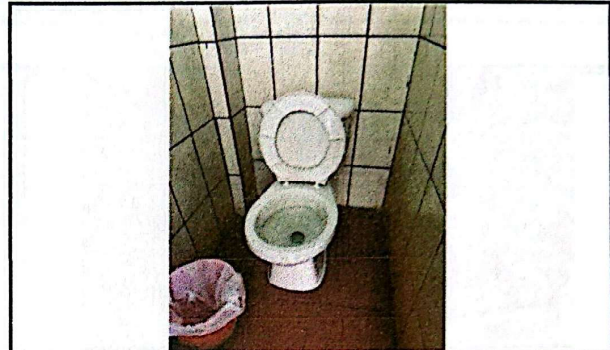
Foto 2: Inodoros nuevos, debidamente instalados.
