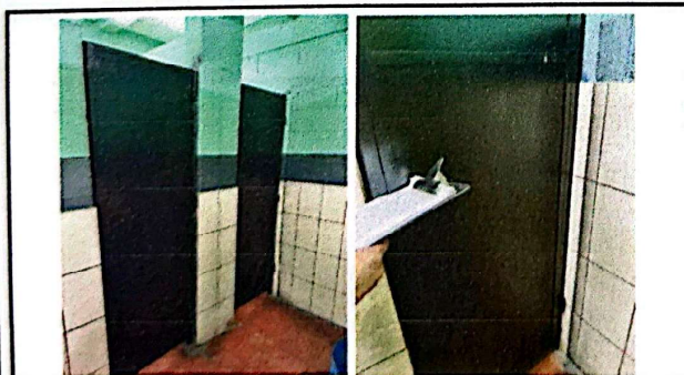
Foto 5: Mantenimiento a puerta metálicas en baño de niñas.
