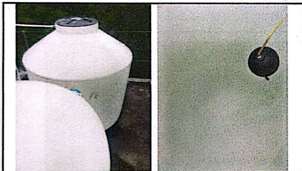
Foto 3: Trabajos de mantenimiento e instalación de nueva red de agua potable realizados.
