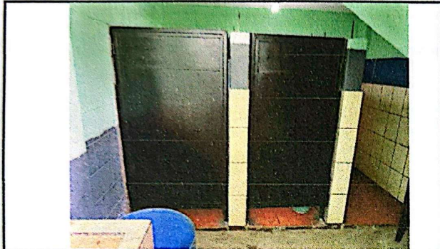
Foto 1: Mantenimiento a puertas de baños de niños, incluye el lijado y la pintura.
