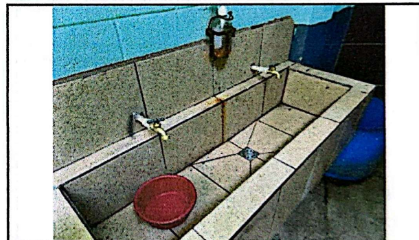
Foto 4: Suministro e instalación de chorros en pilatas.
