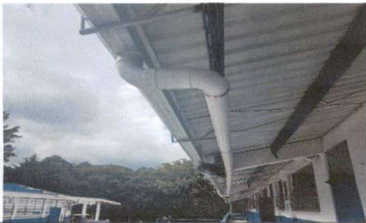
Foto 3: INSTALACION DE CANALES
