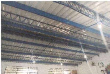
Foto 5 RECOLOCACION DEL SISTEMA ELECTRICO
