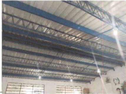
Foto 2: INSTALCION DE COSTANERAS PINTADA,
