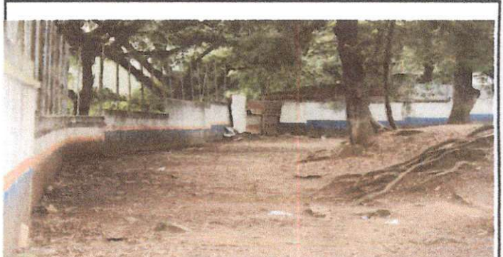
FOTOGRAFIA DEMUESTRA NIVEL DE RAICES EXPUESTAS Y PARTE MURO QUE SE DERUMBO POR MOVIMIENTO DE TIERRA POR EXCESO DE AGUA DE LLUVIAS
