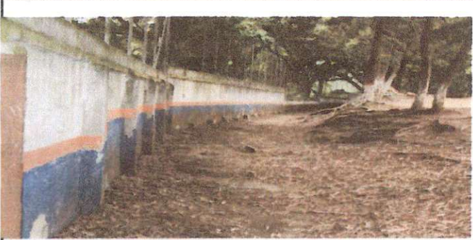
ESTA ES EL AREA A DONDE LLEGA Y SE ACUMULA TODA EL AGUA DE LA LLUVIA Y QUE PROVOCA EROSION DEL TERRENO, DEBIDO A NO CANALIZARLO CORRECTAMENTE POR LOS DRENAJES PLUVIALES
