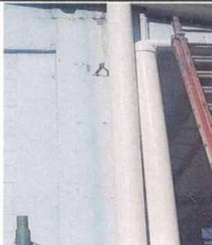
Fotos 5: cambio de tubería por fuga de agua
