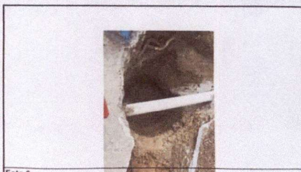
Foto 6: AREA DE TRABAJO, DRENAJE
