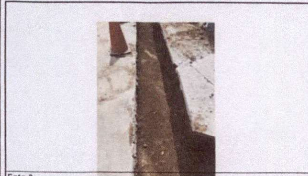
Foto 3: AREA DE TRABAJO, DRENAJE
