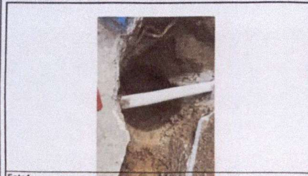
Foto 1: AREA DE TRABAJO, DRENAJE
