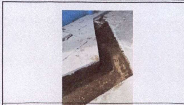
Foto 2: AREA DE TRABAJO, DRENAJE
