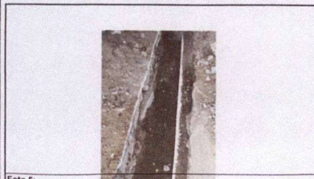
Foto 5: AREA DE TRABAJO, DRENAJE
