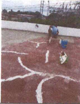
Foto 1: MODULO 2, IMPERMEABILIZACION DE LOSA, AULA PREPARATORIA
