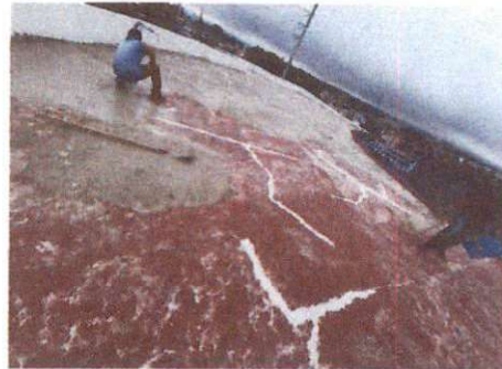
Foto 4: MODULO 2 IMPERMEABILIZACION DE LOSA EN PASILLO
