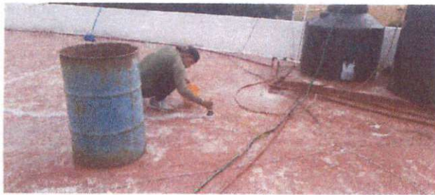
Foto 3: MODULO 2, IMPERMEABILIZACION DE LOSA, AULA DE SEGUNDO
