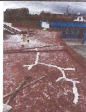
Foto 2: MODULO 2, IMPERMEABILIZACION DE LOSA, AULA TERCERO
