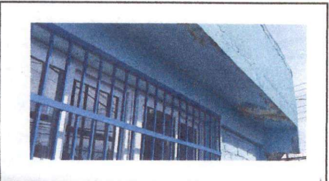
Foto 3: MODULO 2, IMPERMEABILIZACION DE LOSA PARTE EXTERIOR DE AULA SEGUNDO PRIMARIA
