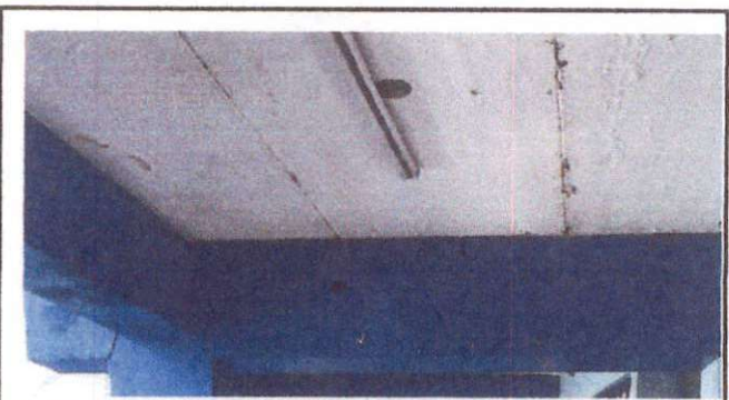
Foto 4: MODULO 2 IMPERMEABILIZACION DE LOSA EN PASILLO
