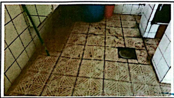
Foto 5: Instalacion de piso ceramico
