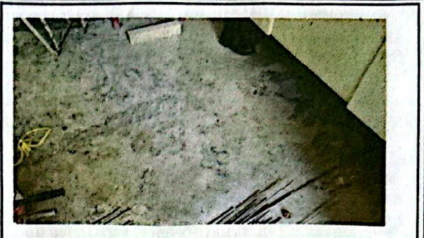
Foto 2: INSTALACION DE PISO EN LABORATORIO DE COMPUTO
