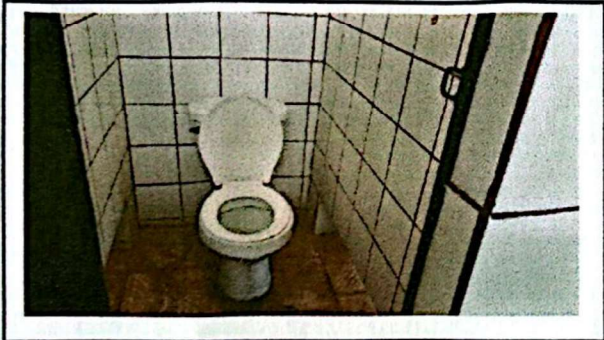
Foto 3: CAMBIO DE SANITARIO
