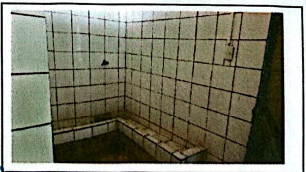
Foto 6: desmontaje de urinal
