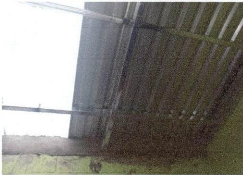
Foto 5: COLOCACIÓN DE TECHO Y COSTANERAS.
