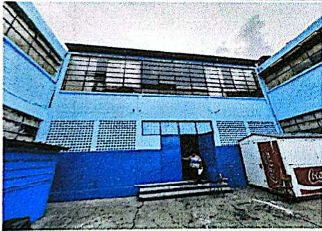
Foto 9: Aplicación de pintura en fachada.
