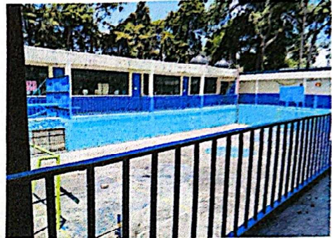
Foto 2: Trabajos de mantenimiento a barandilla.
