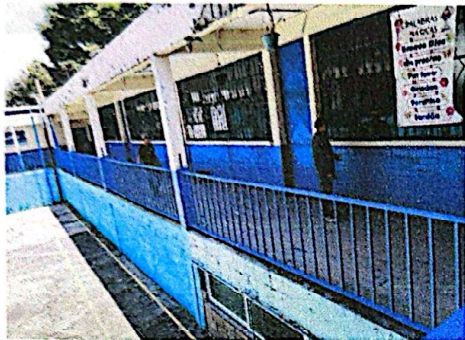
Foto 1: Se terminaron los trabajos de mantenimiento a la barandilla.
