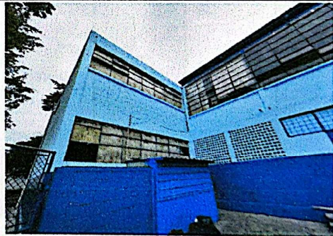
Foto 10: Aplicación de pintura en fachada.
