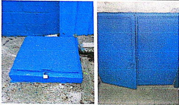
Foto 7: Mantenimiento de puertas para bomba y cisterna, incluye el lijado y pintura.
