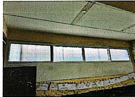
Foto 8: Suministro e instalación de ventana corrediza de UPVC.
