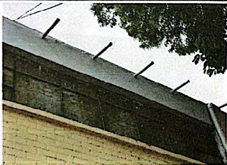
Foto 3: Resultado de los trabajos de resanado de vigas en exterior.
