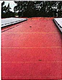
Foto 5: Aplicación de Impermeabilizante en losa.
