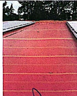
Foto 6: Aplicación de Impermeabilizante en losa.
