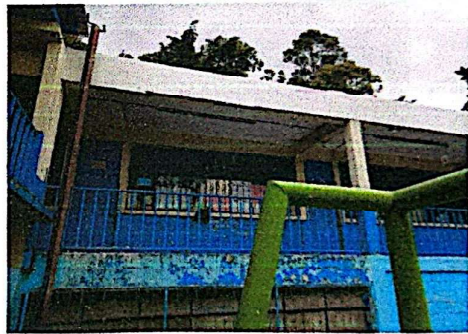
Foto 4: Trabajos de resanado de vigas en interior.
