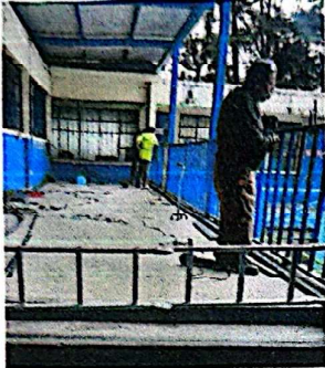
Foto 1: Trabajos de mantenimiento a barandilla.
