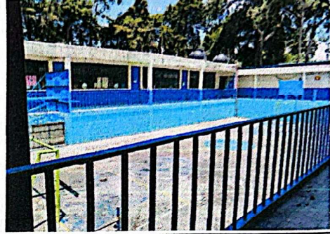
Foto 2: Trabajos de mantenimiento a barandilla.
