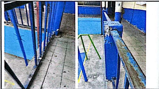
Foto 3: Mantenimiento a barandilla de pasillos en el edificio del establecimiento, incluye lijado, pintura y colocación de piezas faltantes.
