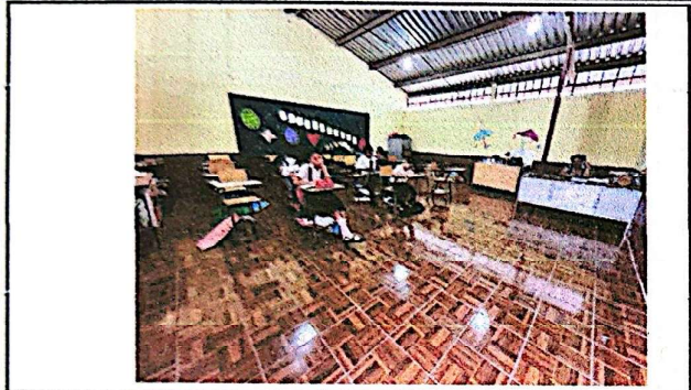
Foto 7: Suministro e instalación de piso cerámico.
