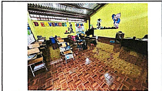
Foto 10: Se muestra uno de los salones con cambio de piso.
