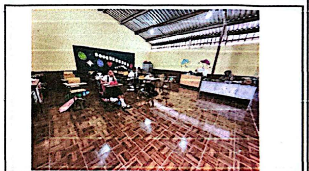
Foto 10: Se muestra uno de los salones con cambio de piso.
