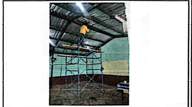
Foto 8: Se lleva a cabo el mantenimiento a la estructura de soporte.
