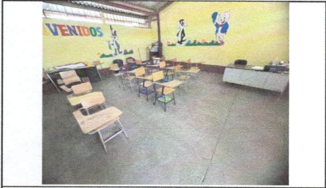
Foto1: . Salones en los cuales se cuenta con la fundición de torta de concreto, por lo que se desea colocar piso para mejorar la calidad del espacio.
