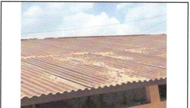
Foto 10: Vista desde el exterior del techo perteneciente a los servicios sanitarios.
