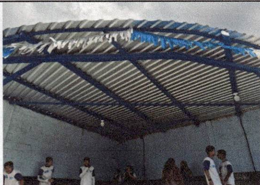
Foto1: Cambio de techo
