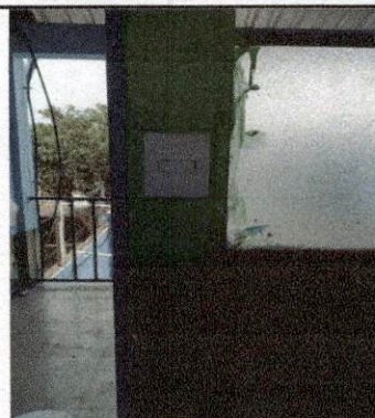
Foto 2: Colocación de apagadores nuevos en aulas
