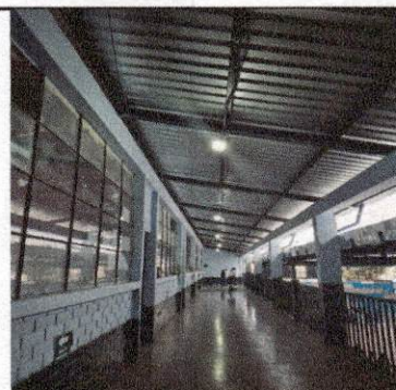
Foto 6: Instalación de energía eléctrica en pasillos de segundo nivel.
