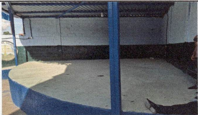
Foto 3: Cernido y Pintura en suelo.
