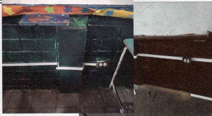
Foto1: Instalación de tomacorrientes en aulas
