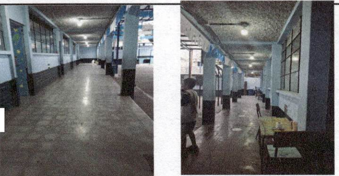
Foto 5: Instalación de energía eléctrica en pasillos de primer nivel.
