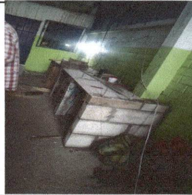
Foto 4: Fundición de plancha de Block en cocina.
