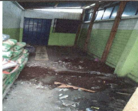
Foto 4: Escabación para implementación de drenaje.
