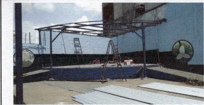
Foto1: Sustitución de lamina en mal estado por nueva
