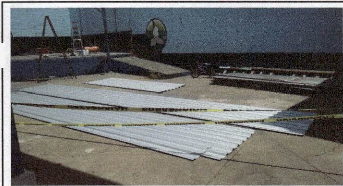
Foto 3: Instalación de nueva lamina.
