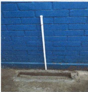
Foto 5: Implementación de tubería para agua potable.
