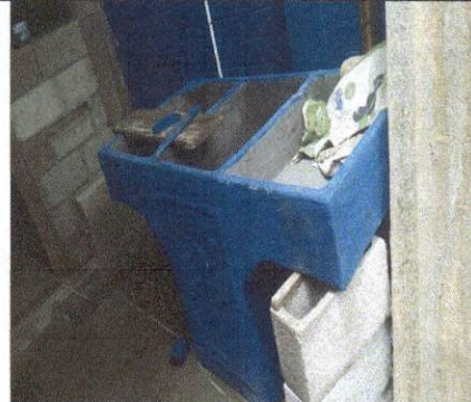
Foto 6: Colocación de pila de cemento, para el uso de la cocina.
