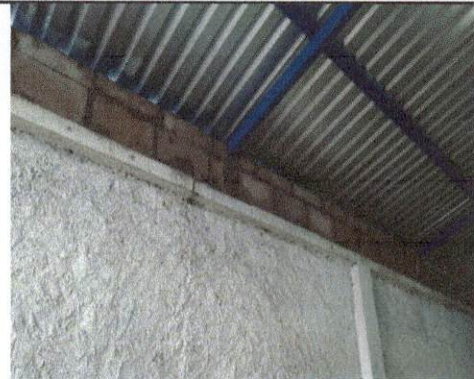
Foto 4: Hilladas de block para mejorar altura.
