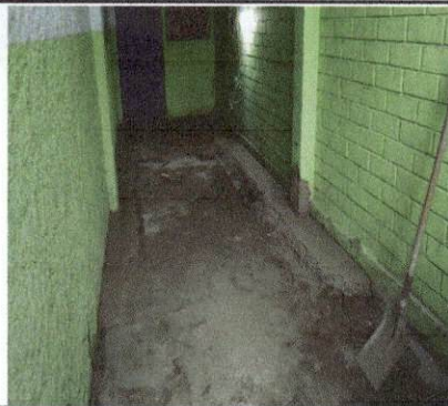
Foto 5: Nivelación de suelo
