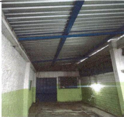
Foto 3: Colocación de lamina
