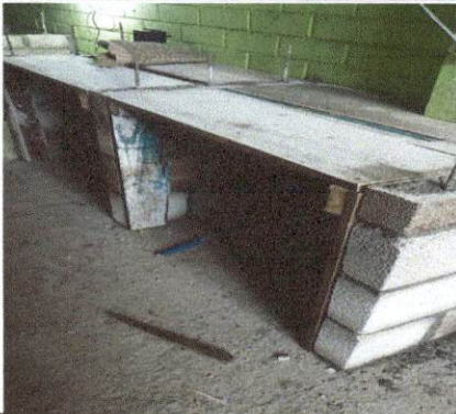
Foto 3:Construcción de plancha de block
