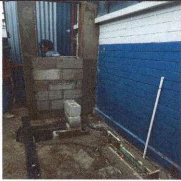
Foto1:elabocación de denaje.
