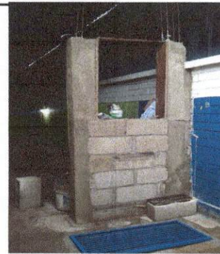
Foto 6: Sustrucción de pared de lamina por block para mayor seguridad.
