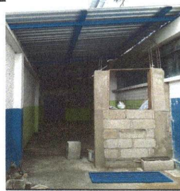
Foto 2: Visualización de avance en cocina
