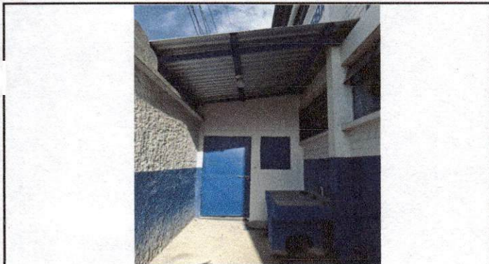
Foto 3: Colocacion de lamina sobre espacio de pila.
