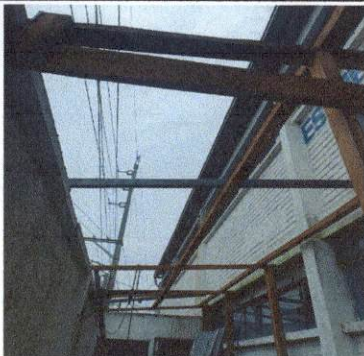
Foto 5: Se elimina lamina en mal estado.
