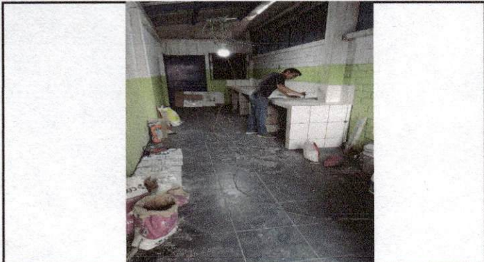
Foto1: colocacion de piso y azulejo en plancha de cocina
