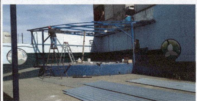
Foto 2: Mantenimiento a estructura de metal y pintura.
