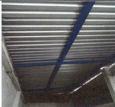
Foto 1: Sustrucción de techo.
