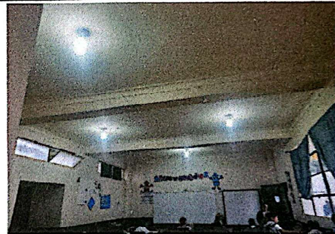
Foto 10: Suministro e instalación de lámparas para salón de clases.
