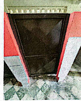
Foto 2: Mantenimiento a puertas metálicas, incluye lijado y pintura.
