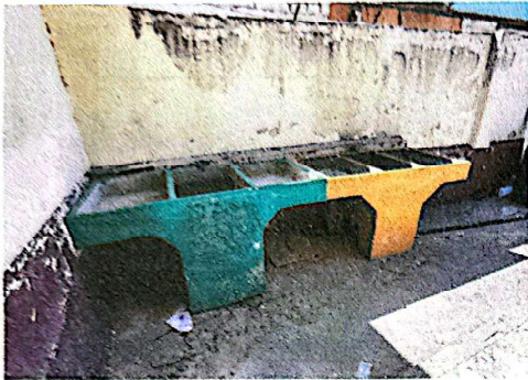
Foto 7: Suministro e instalación de pilas.
