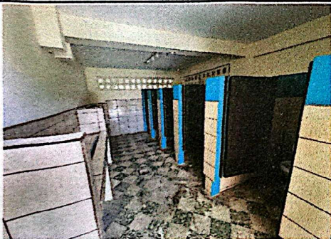
Foto 3: Mantenimiento a puertas + pintura interior + suministro e instalación de azulejo.
