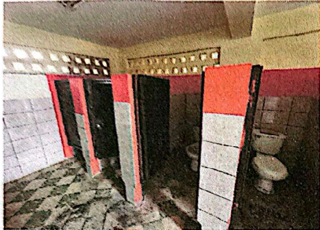
Foto 1: Aplicación de pintura en muros interiores de baños.
