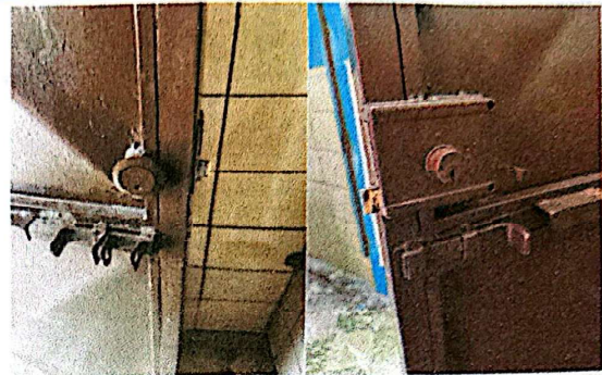
Foto 8: Colocación de chapa en puerta principal de baño.
