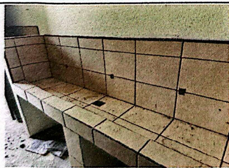
Foto 5: Se sustituyó el azulejo en mal estado por azulejo en buenas condiciones en pileta tipo lavamanos.
