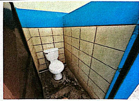
Foto 4: Instalación de azulejo en baños.
