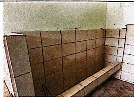
Foto 6: Suministro e instalación de azulejo el mijitorio.
