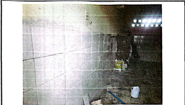
Foto 7: Se lleva a cabo la instalación del azulejo en muros.
