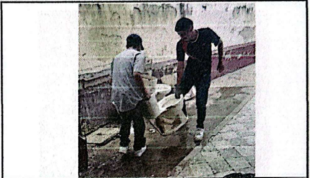
Foto 2: Retiro de inodoros que serán desechados y sustituidos.
