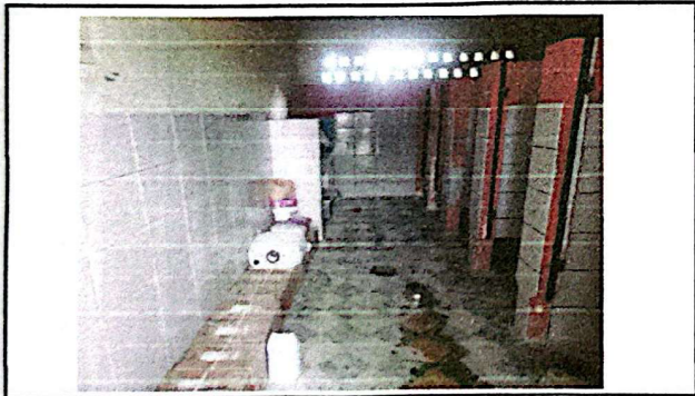
Foto 9: El baño de chicas es el que muestra el mayor avance con respecto a la colocación del azulejo.
