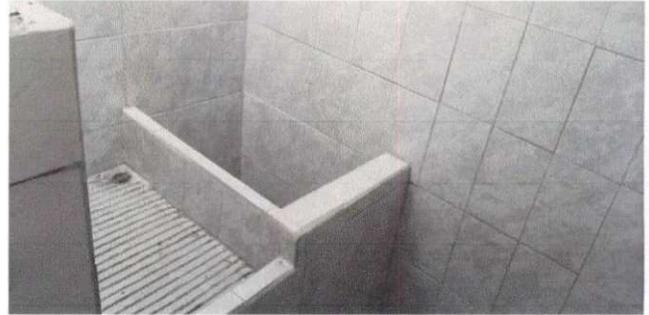
Foto 2: - Sustitución de pila de cemento- Reemplazo de azulejo
