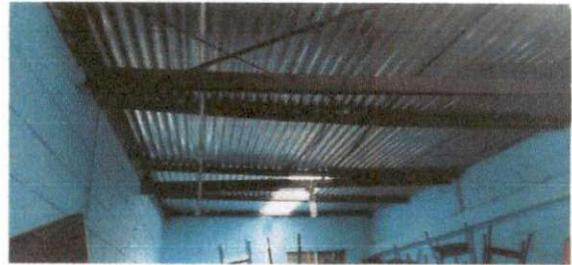
Foto 4: - Reemplazo de techado en bodega con lámina troquelada nueva
