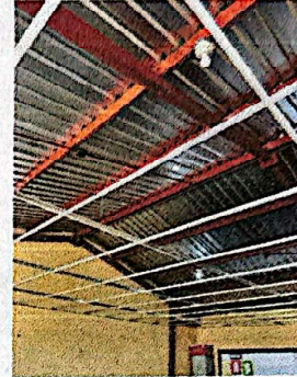
Foto 2: Mantenimiento de estructura metálica de soporte incluye lijado y pintura.
