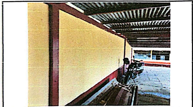
Foto 9: Se aplicó repello y pintura para el acabado final.
