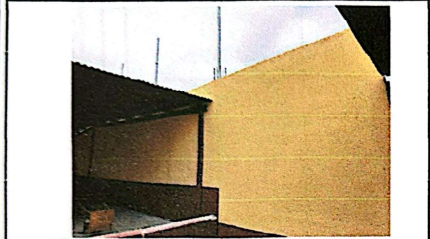
Foto 7: Muro perimetral de mampostería reforzada.
