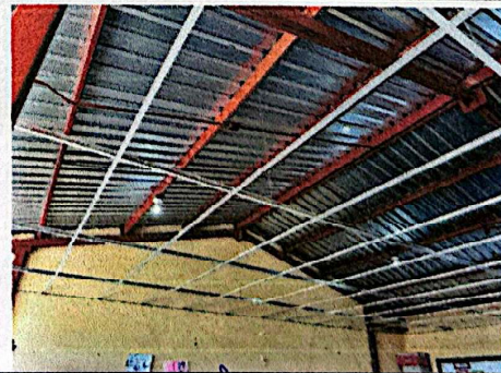
Foto 6: Suministro e instalación de techo de lámina + mantenimiento de estructura de soporte.
