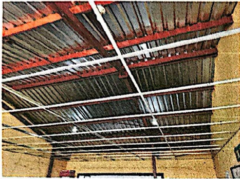
Foto 1: Suministro e instalación de techo de lámina
