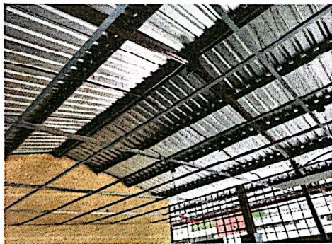
Foto 3: Instalación de techo de lámina.
