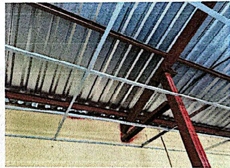
Foto 4: Colocación de lámina troquelada calibre 26.
