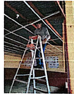
Foto 10: Mantenimiento a estructura de soportes.
