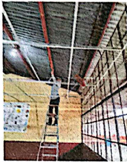
Foto 7: Limpieza de estructura metálica.
