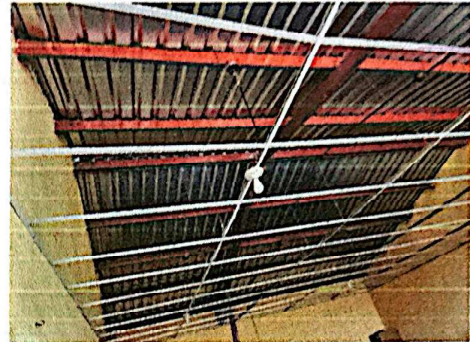
Foto 8: Suministro e instalación de lámina troquelada.
