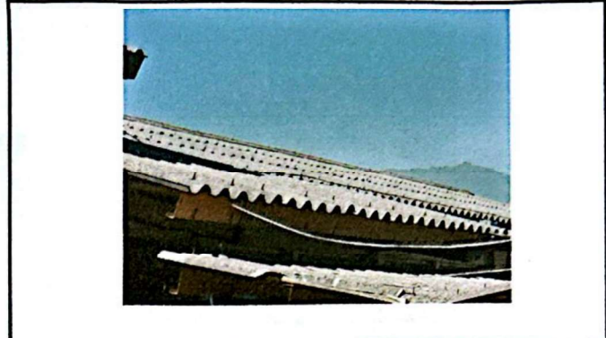
Foto 2: MÓDULO DE AULAS, EL TECHO ES DE DURALITA.
