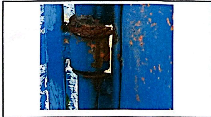
Foto 5: ÁREA DE PORTONES, PORTÓN GRANDE TIEN ÓXIDO EN LA BISAGRAS.
