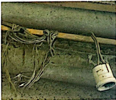
Foto 5: ÁREA DE REPARACIÓN DE SISTEMA ELÉCTRICO, REEMPLAZAR EL CABLEADO PARA EVITAR ACCIDENTES.
