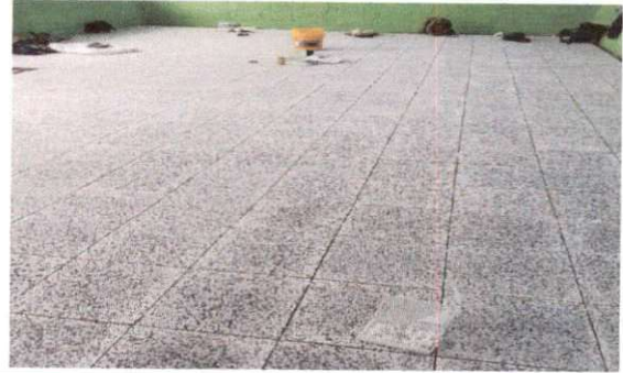
Foto 8: Cambio de piso aula 2
