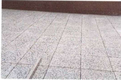
Foto7: Cambio de piso aula 1
