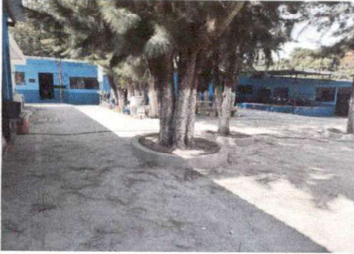
Foto 1: Losa de Patio.
