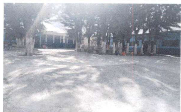
Foto 2: 2da parte de losa de patio.
