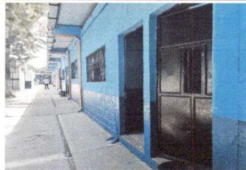
Foto 6: Repello y pintura
