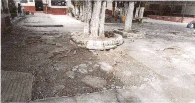
Foto 1: Losa de Patio.
