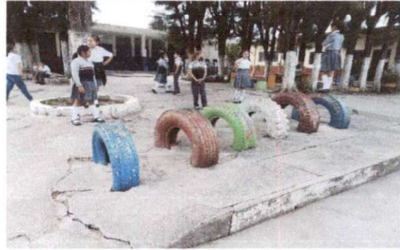
Foto 2: 2da parte de losa de patio.
