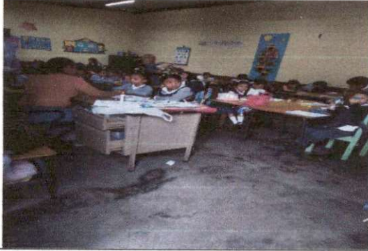
Foto 7 : Cambio de piso aula 1
