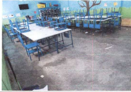
Foto 8: Cambio de piso aula 2
