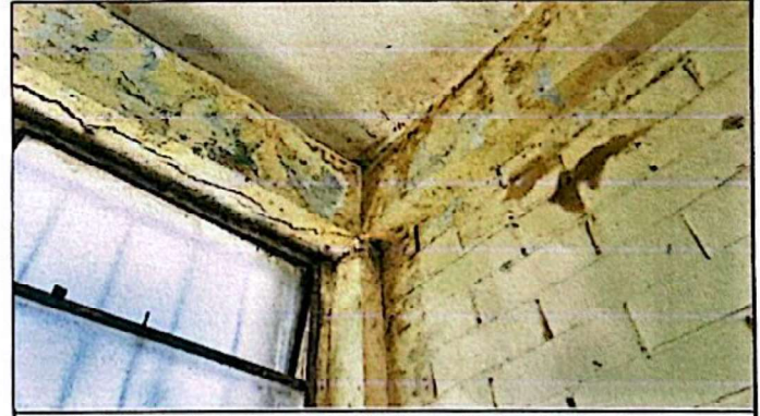
Foto 4: Reparación de viga quebrada 30cm x 30cm x 6mts
