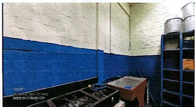
Foto 3: Instalación de 6mts2 del área de cocina para poner azulejo en la pared por higiene
