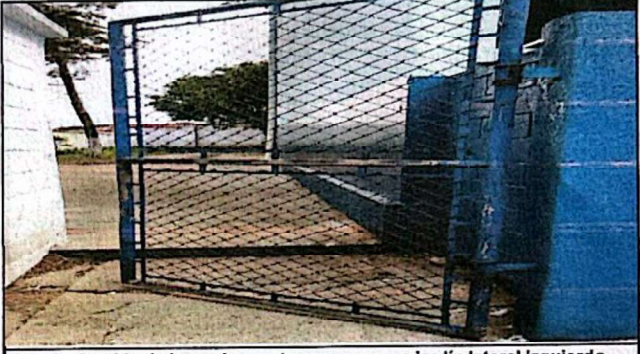
Foto 2: Cambio de lugar de puerta con acceso a jardín lateral izquierdo
