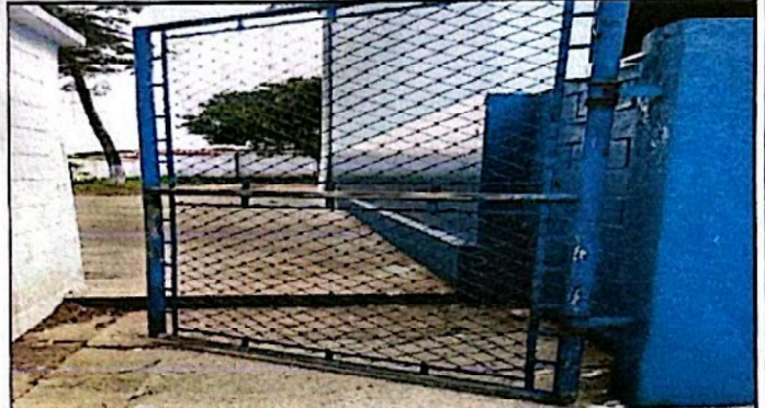
Foto 2: Cambio de lugar de puerta con acceso a jardín lateral izquierdo
