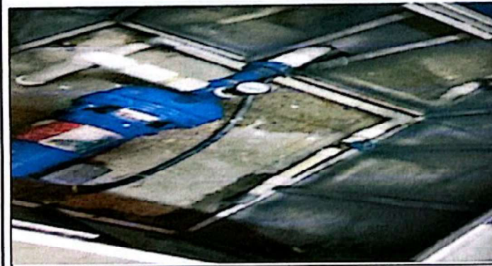
Foto 5: Reparación y mantenimiento de fuga de bomba de sistema de escuela Ruben Dario
