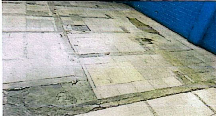
Foto 1: Desmontaje de piso quebrado y viejo e instalación de piso nuevo 6mts x 5mts
