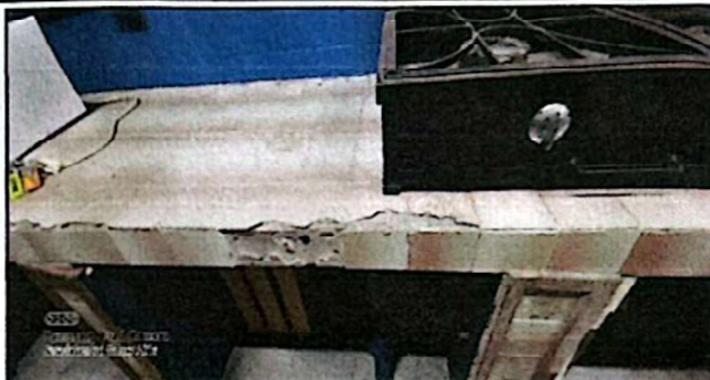
Foto 2: Reparación de 10mts2 de desayunador destruido y en malas condiciones
