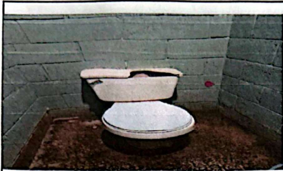
Foto 1 Desmontaje y montaje de 14 sanitarios Módulo 1
