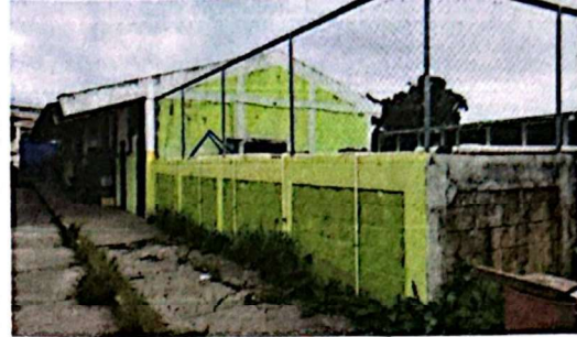
Foto 20: Pintura Interior pared de la finalizacion del modulo 4
