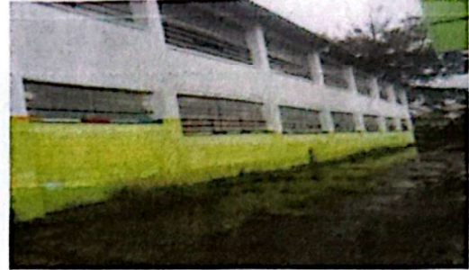
Foto 14: Pintura Interior Módulo 1 pared de atrás del módulo son dos niveles
