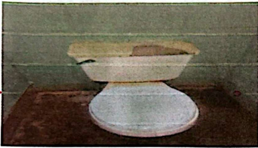
Foto 3: Desmontaje y Montaje de 14 Sanitarios Módulo 3
