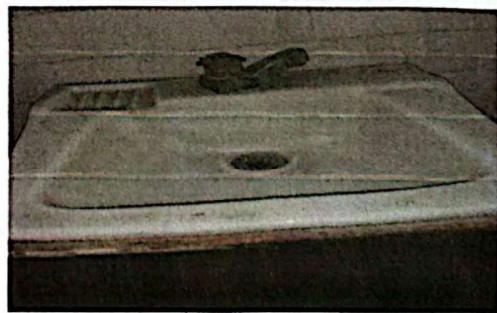
Foto 6: Desmontaje y montaje de 4 lavamanos Modulo 3, en cada baño hay 3 lavamanos, se quitaran y solo se colocara 1 por baño es por eso que se colocaran 4 lavamanos por modulo
