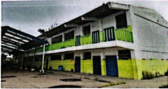
Foto 13: Pintura interior Modulo 1 pared del area de las aulas son dos niveles por modulo
