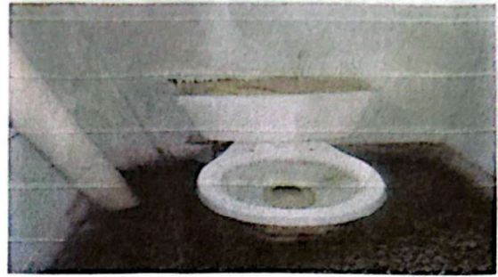
Foto 2: Desmontaje y montaje de 14 Sanitarios Módulo 2
