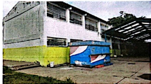
Foto 16: Pintura Interior Módulo 2 pared de atrás son dos niveles
