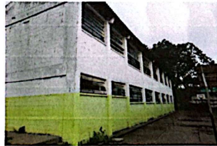
Foto 18: Pintura interior Modulo 3 pared de atrás son dos niveles
