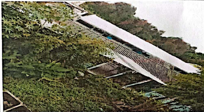
Foto 1: REPARACION DE LA INFRAESTRUCTURA DEL TECHO DEL MODULO "A"
