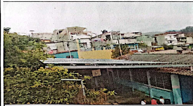
Foto 3: REPARACION DE LA INFRAESTRUCTURA DEL TECHO DEL MODULO "A"
