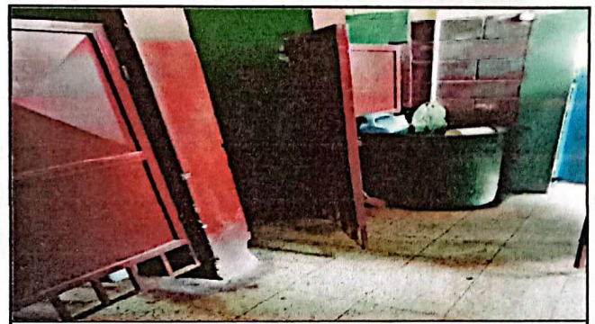
Foto 4: REMOZAMIENTO DE SERVICIOS SANITARIOS, PUERTAS, PAREDES, DESMONTAJE Y LIMPIEZA DE SANITARIOS.
