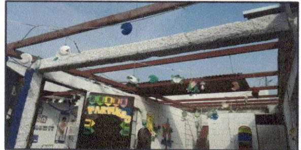
Remodelación de Aula en el modulo 3
