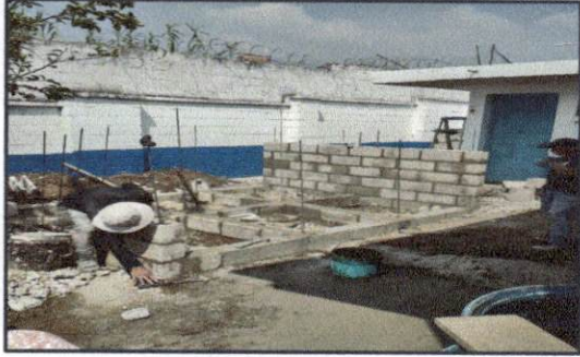
Ampliación de baños en el módulo 1
